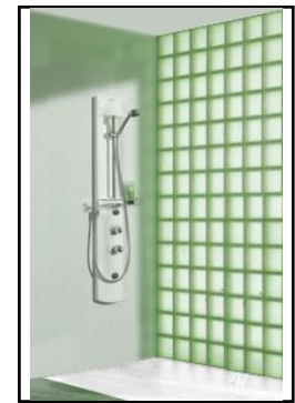
PARETE DIVISORIA TRA BAGNO E LAVANDERIA IN VETROCEMENTO
